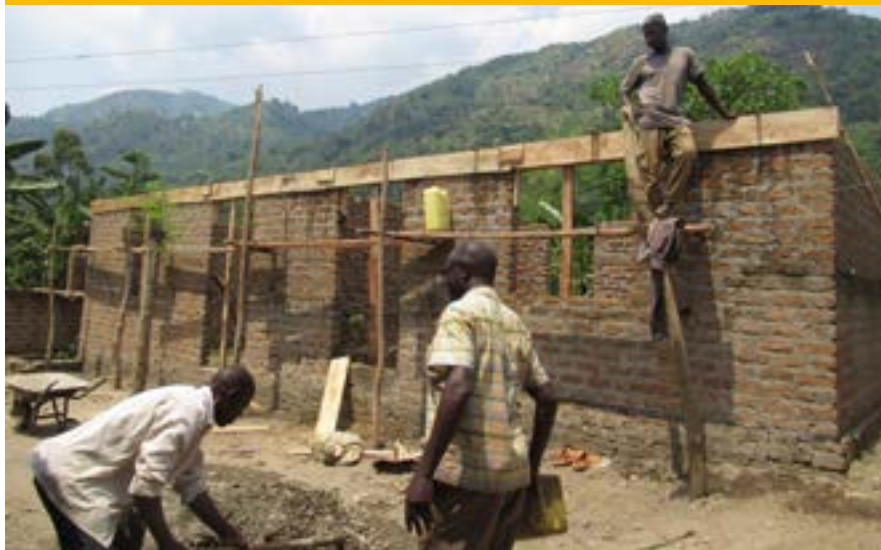
Hier entsteht ein Lernzentrum für die Basua. Bis dahin konnte der Bau während unseres Aufenthaltes wachsen.
