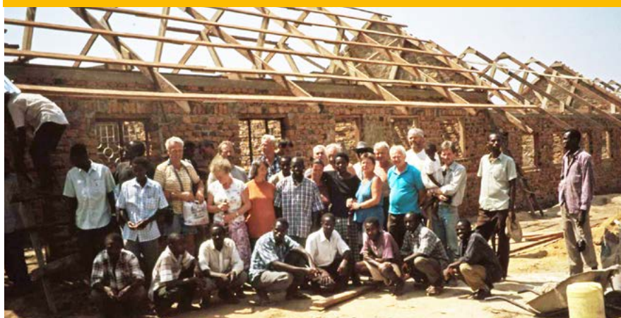
In Kihikihi fand 2000 unser erster Baueinsatz statt. Am Ende stand der Rohbau einer Grundschule.
