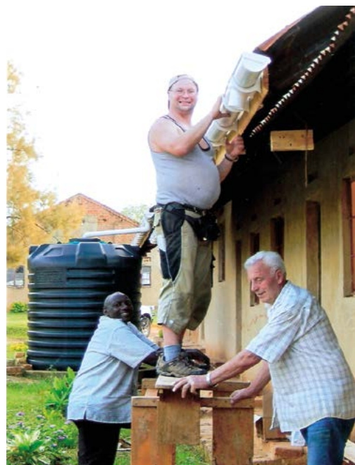
Erweiterung der Dachrinnen. Dadurch wird mehr Regenwasser gewonnen.
